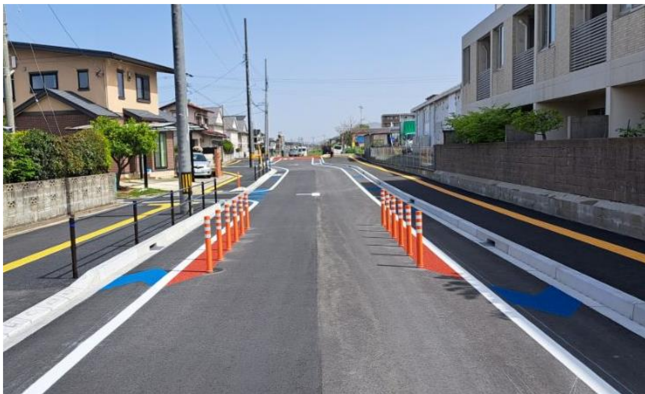
整備が完了した西鉄宮地岳線跡地
