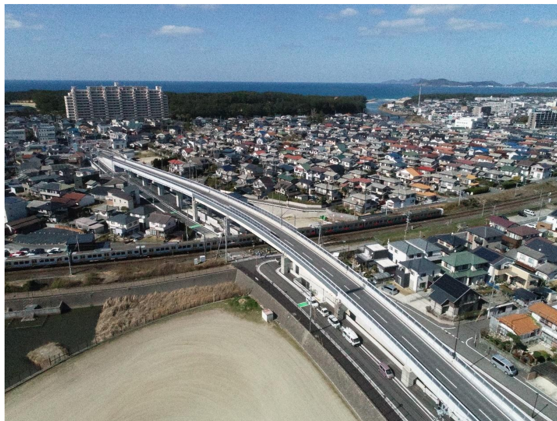
整備が完了した「浜大塚線」
